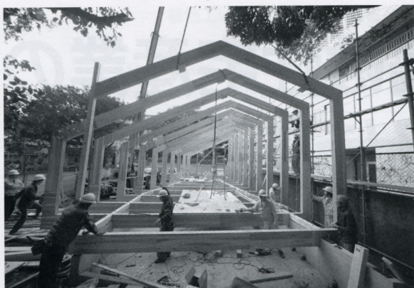
建設中のOcha House。パネルをフレーム状にして並べている
