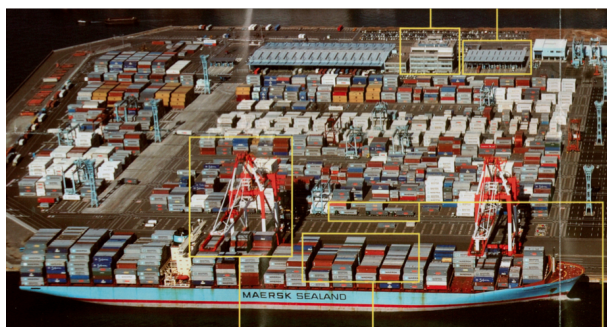
図1: 横浜港南本牧埠頭コンテナターミナル [3].
